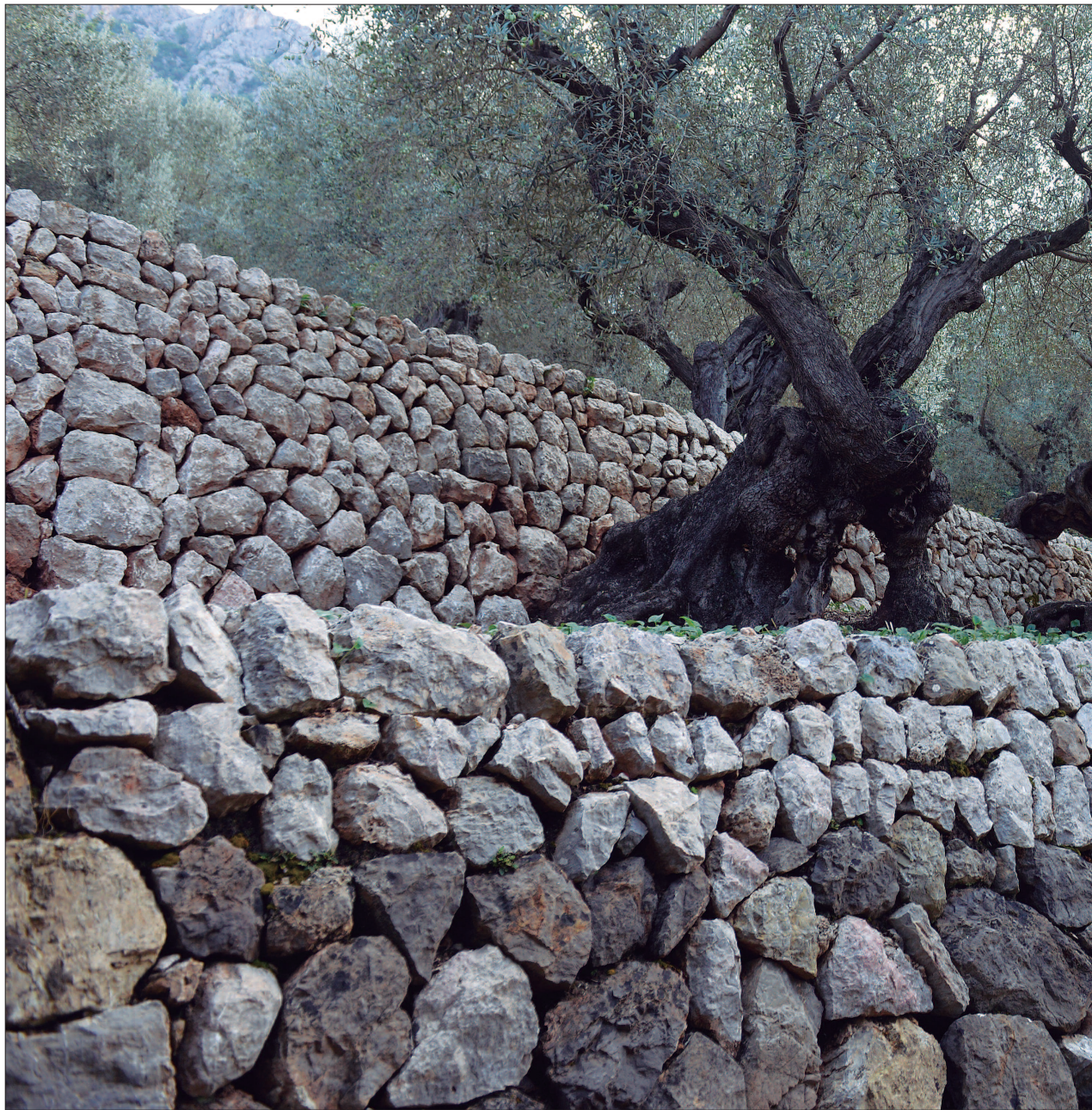
Alguns dels marges que sostenen la terra a la Serra de Tramuntana i eviten la seva erosió, obra de margers anònims que actualment
