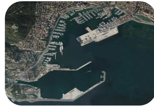
Infraestructures a línia de costa
