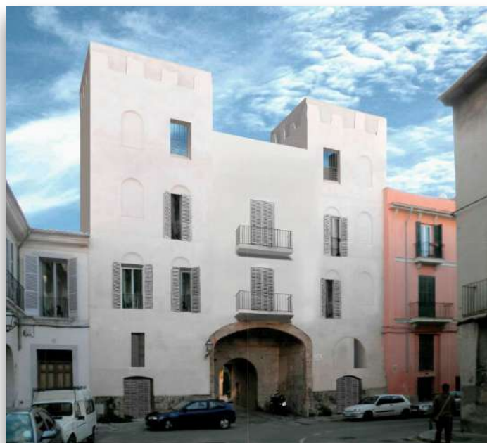
Imatge de com quedarà la façana de les Torres del Temple després de la seva rehabilitació.
