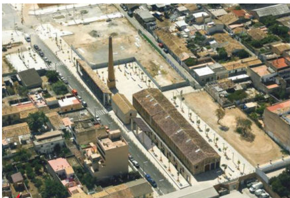
12. REHABILITACIÓ DE CAN RIBAS Jaime J. Ferrer, 2011
