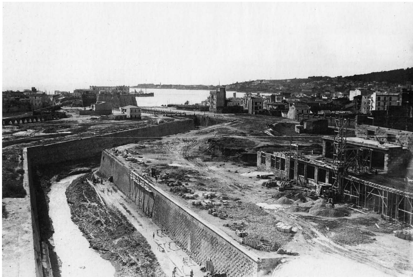
Construcció del Frontón Balear. 1934. Arxiu Vila. Publicada a "Palma 1931-1936" de Xavier del Hoyo i Arnau Company.
