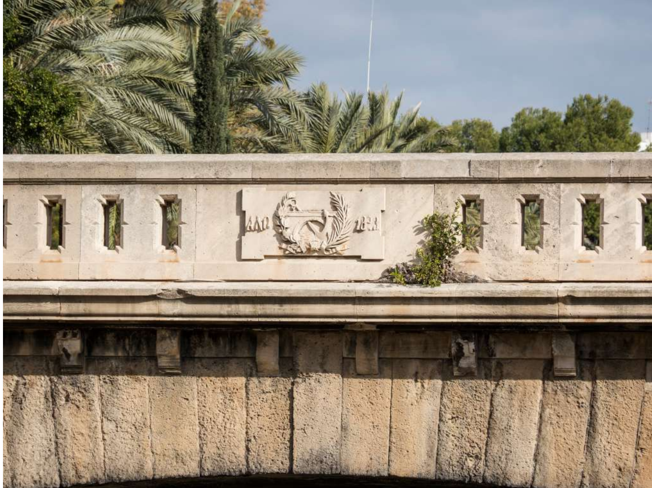
Detall de la placa del pont d'Eusebi Estada. Foto: Jaume Gual.
