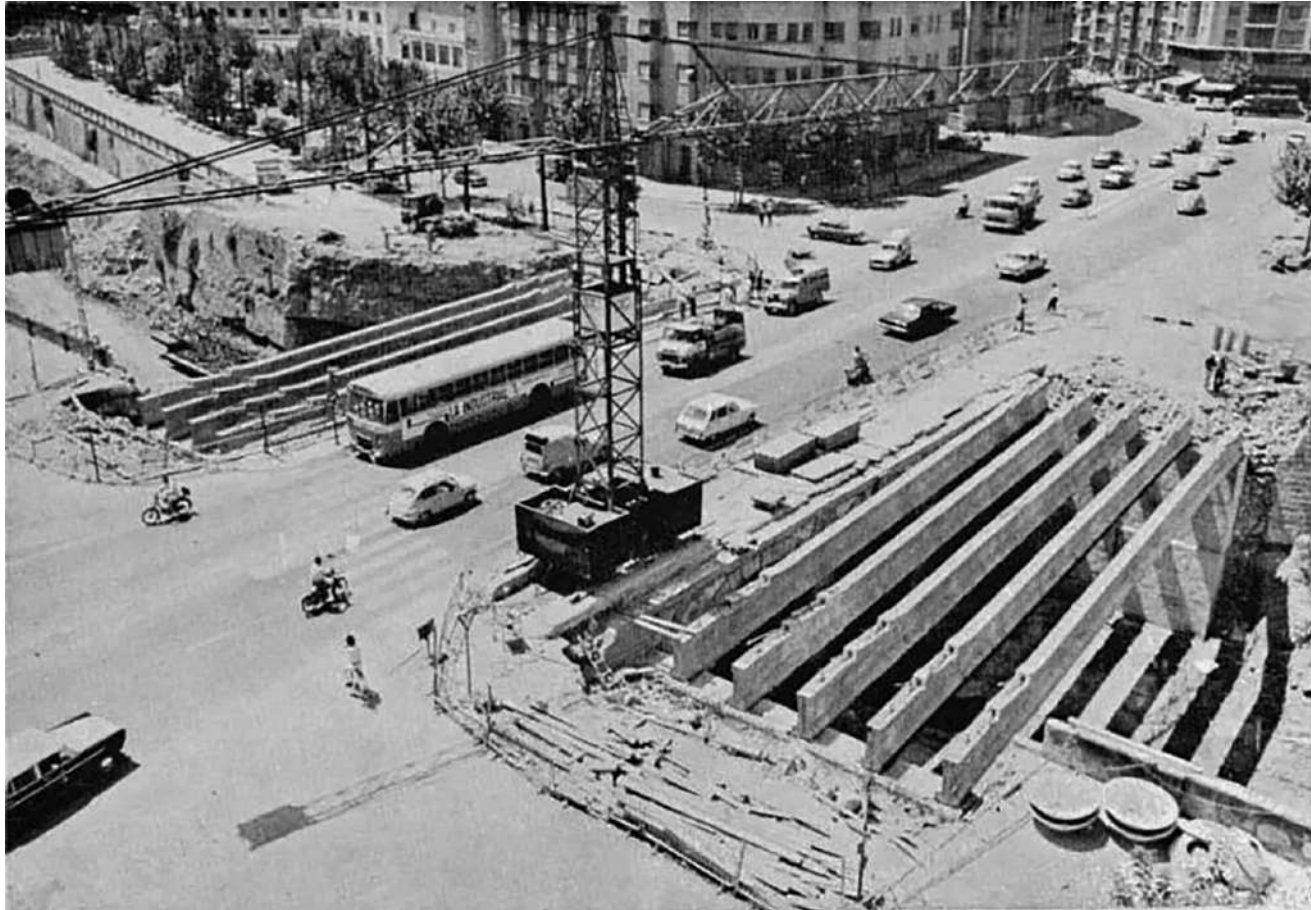
Imatge de l'eixamplament del pont des Fortí als anys 70. Font: Col·lecció particular.
