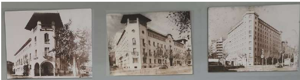
Seqüència d'imatges que mostren les successives reformes a l'edifici de la Clínica Rotger. Font: clinicarotger.com
