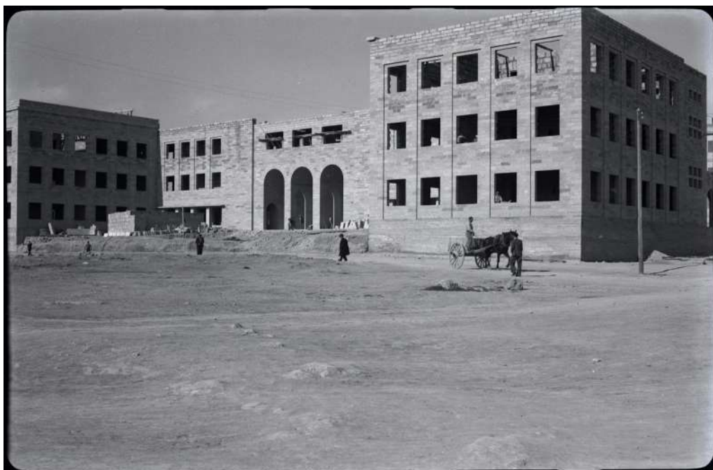
El Grup escolar Jaume I durant les obres d'edificació. Font: ceipreijaumei.com
