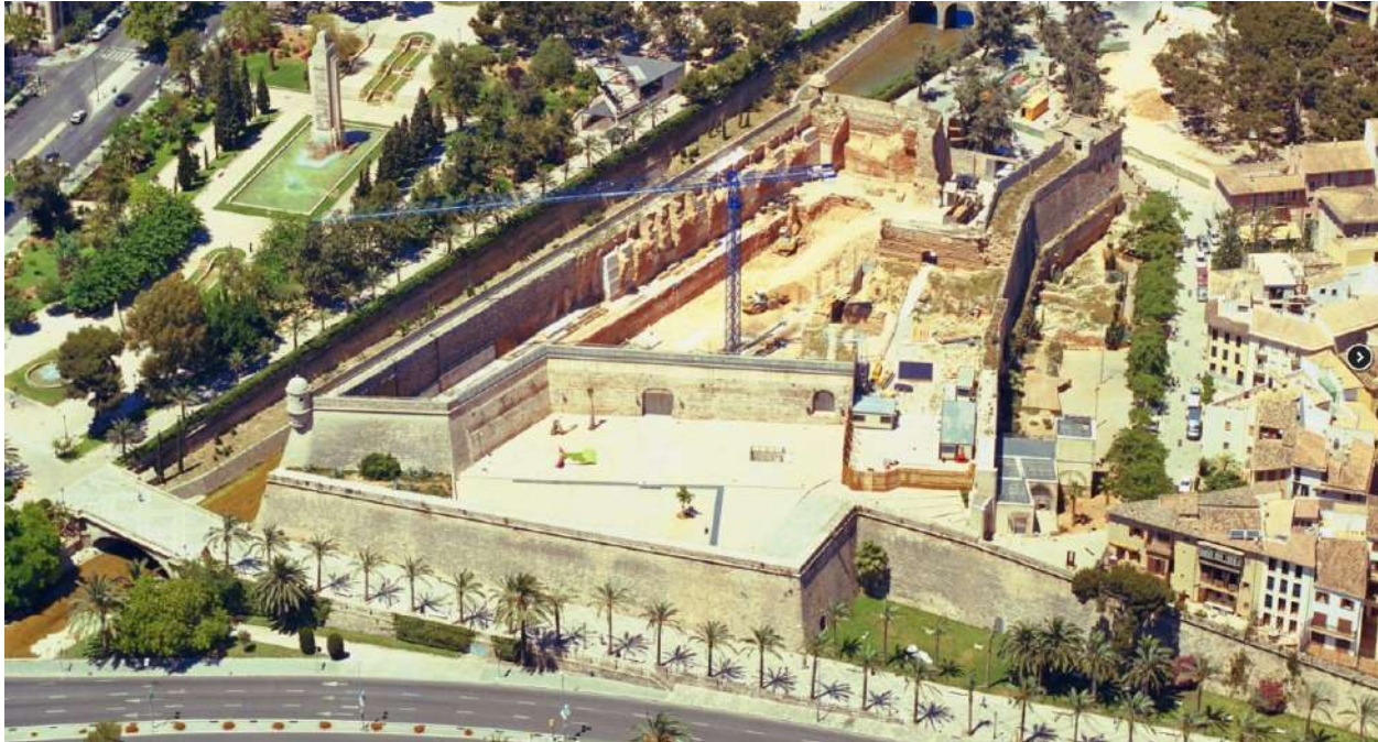
Imatge de les obres al Baluard de Sant Pere. Font: sctarquitectos.com
