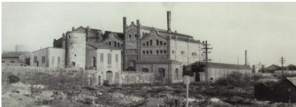
Central elèctrica davant la mar. Arxiu Andreu Muntaner.
